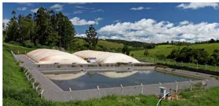
Figura 3.7 – Biodigestor modelo canadense
