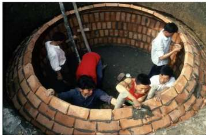
Figura 3.3 – Biodigestor modelo chinês em construção
