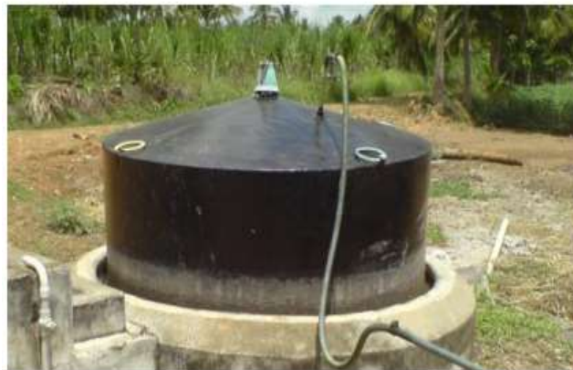
Figura 3.5 - Biodigestor modelo indiano
