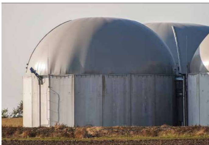
Figura 3.8 – Reator Contínuo de Mistura Completa – CSTR
